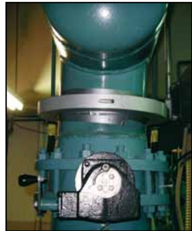
USA, NY-Justizgebäude (12" Ring)
