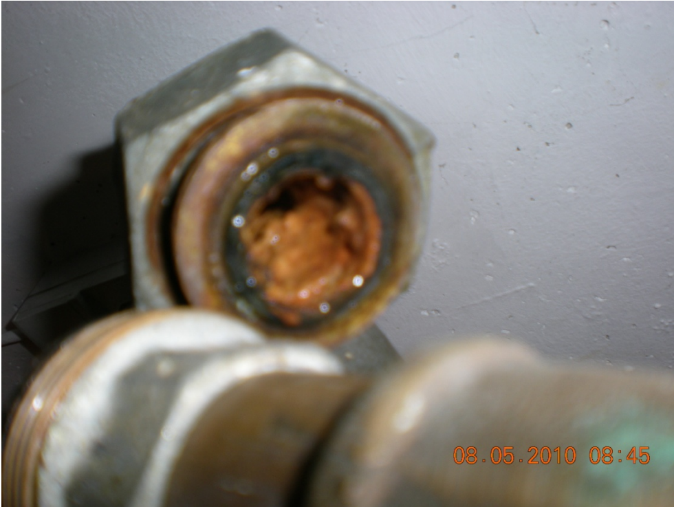
Wasserleitung vor Ringeinbau
