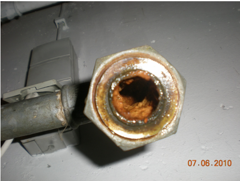
Wasserleitung nach Ringeinbau
